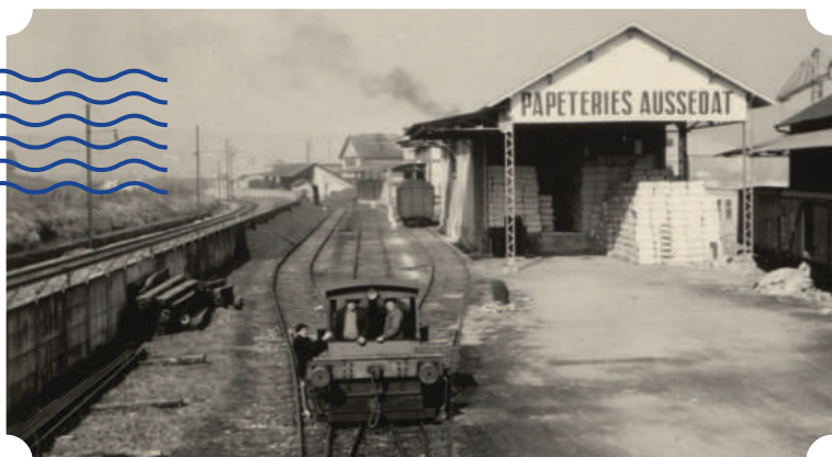
Voie ferrée desservant les Papeteries, rive gauche du Thiou, vue sur les entrepôts de stockage. ©Arch. dép. Haute-Savoie. 151 J 1999
