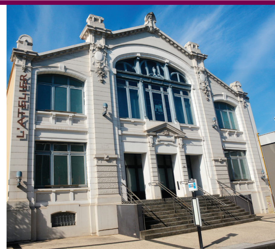
La façade est de l'Atelier (côté boulevard Louis Blanc)
