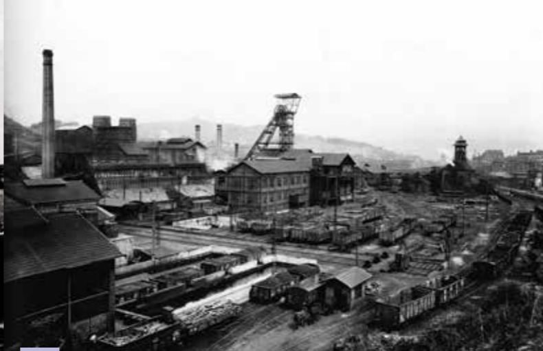
Importance du site du puits Couriot en 1924.
